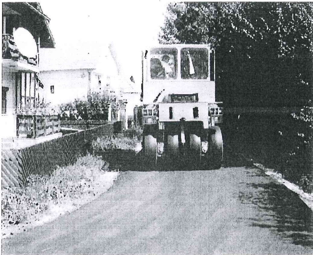
Слика 4. Збијање рециклираног асфалта у околини Јагодине.
